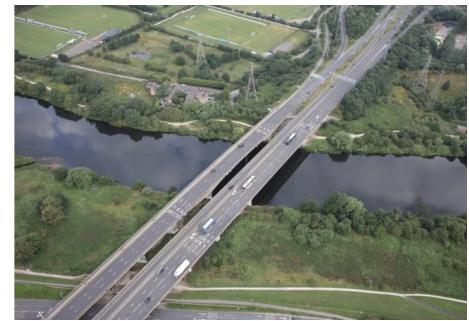
En 1972, el puente fue ampliado y desdoblado con 4 carriles en cada sentido. En 1994, una inspección reveló daños por corrosión hasta en un 25% de los cables pretensados, tras lo cual el puente fue reforzado mediante postensado con cables externos adicionales.
